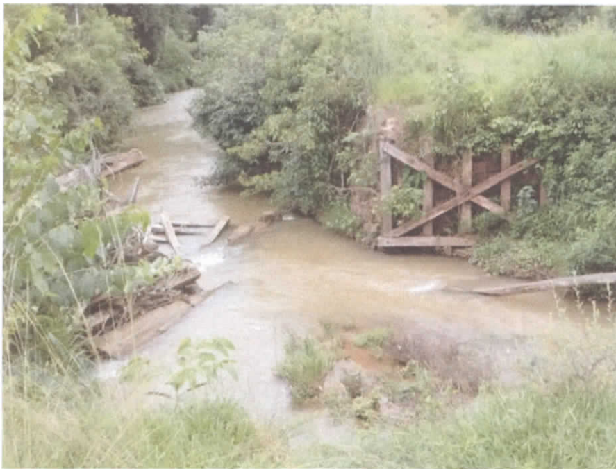
Foto 03. Ponte sobre o Rio Lagoinha. Chapada dos Guimarães – MT.
