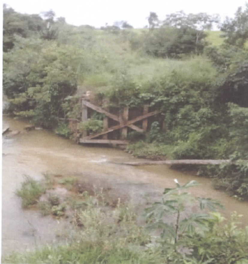
Foto 01. Ponte sobre o Rio Lagoinha Chapada dos Guimarães – MT.
