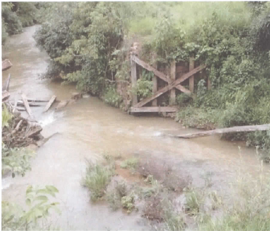
Foto 02. Ponte sobre o Rio Lagoinha. Chapada dos Guimarães – MT.
